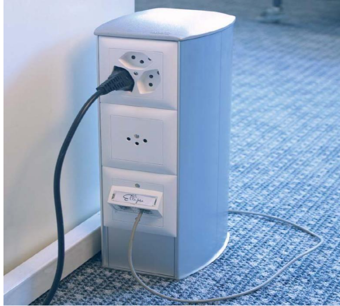
شكل رقم ٩٩: المقابس (البراييز) المصفوفة (Column Sockets)
