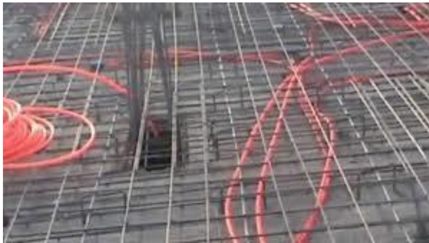
شكل رقم ٨٣: صورة توضح تجهيز المواسير
