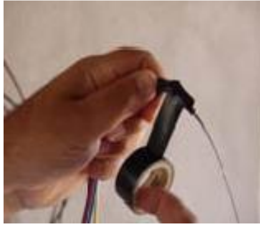
شكل رقم ١٥٤: ربط أطراف الأسلاك المراد سحبها في حلقة سوستة السحب
