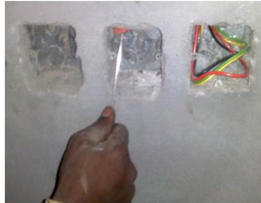
شكل رقم ١٥٥: سحب السلك عن طريق السوستة
